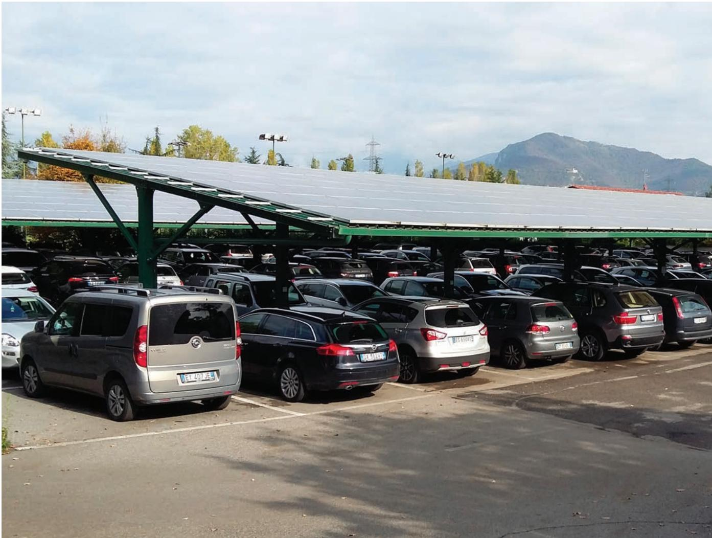
portato alla realizzazione di un impianto fotovoltaico formato da moduli Solar M430 e di un inverter da 80 kW che consentono di soddisfare circa il 60% del fabbisogno annuo energetico totale del club, stimato attorno ai 215.6 Mwh e che permette di evitare l'emissione di 47 tonnellate di CO2 all'anno.
